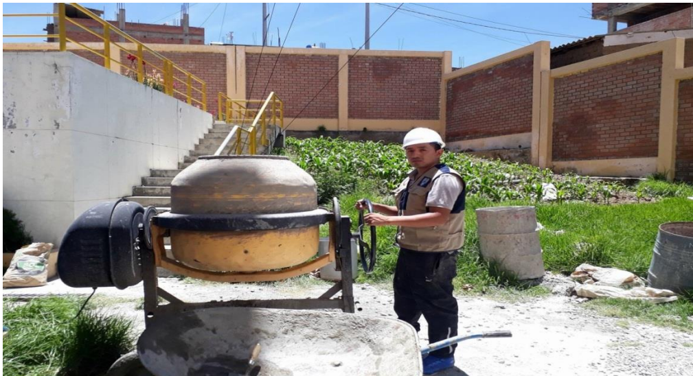
Foto N° 6 Realizando la mezcla homogéneamente con la mezcladora
