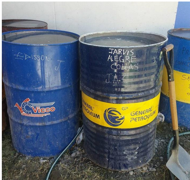
Foto N° 10 Sumergiendo las probetas realizadas para su respectivo curado
