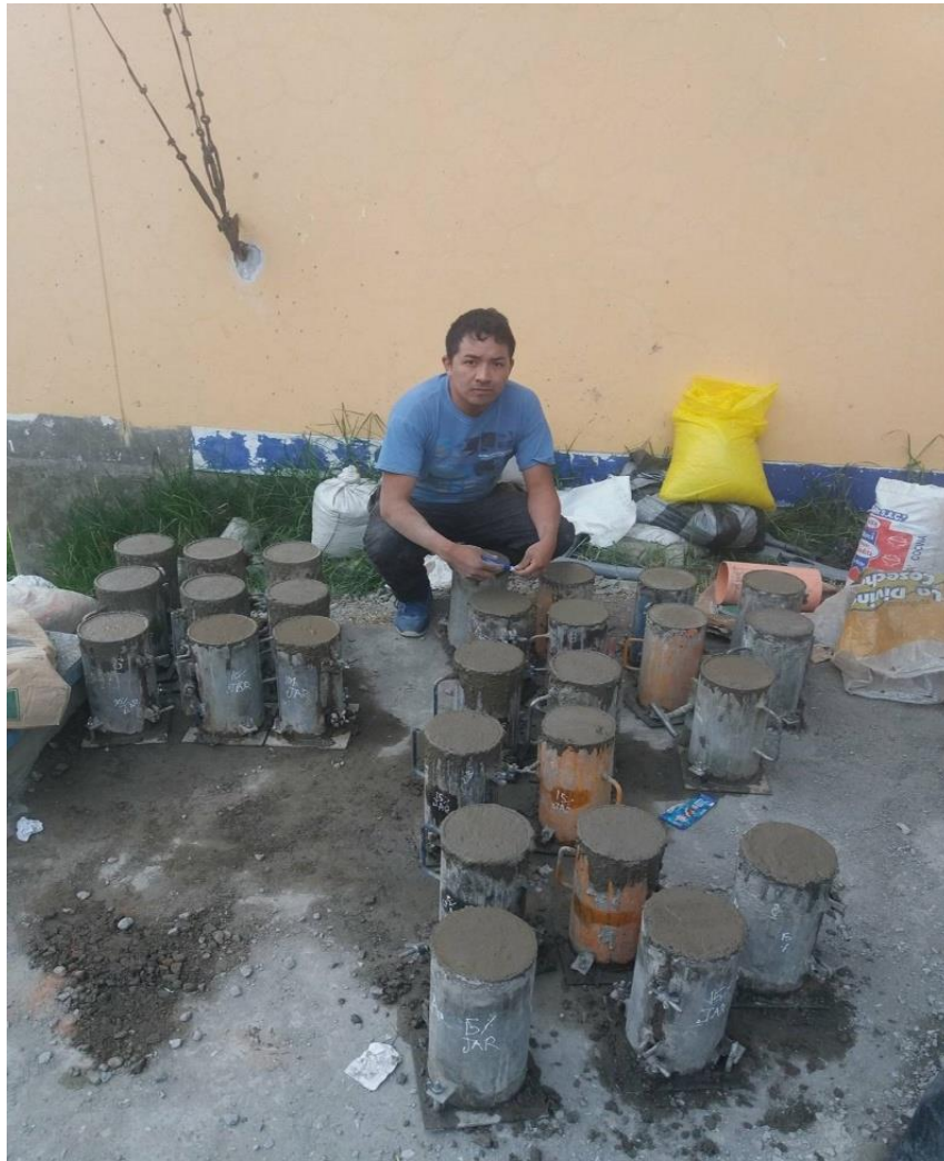
Foto N° 7 Finalizando con el vaciado de todas las probetas
