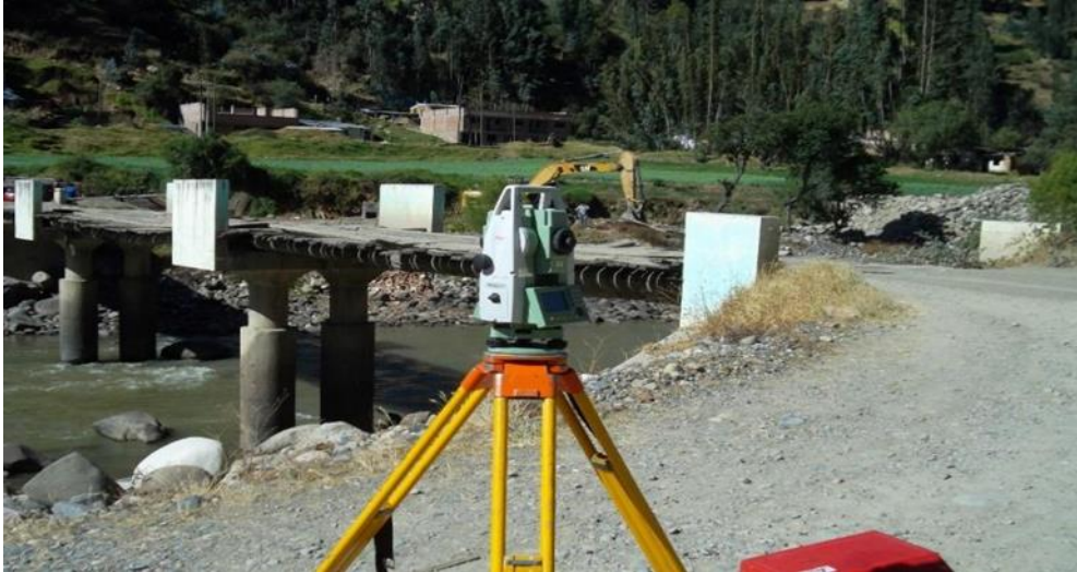
Levantamiento topografico del Puente Tara
